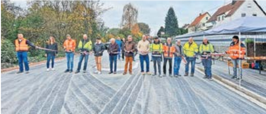
Freie Fahrt: Die Ortsdurchfahrt in Illdorf ist wieder freigegeben.
